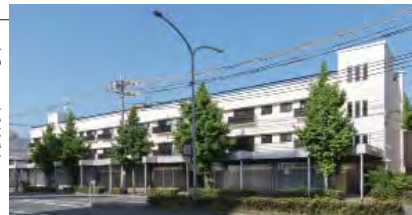
外観：出水団地第三棟
