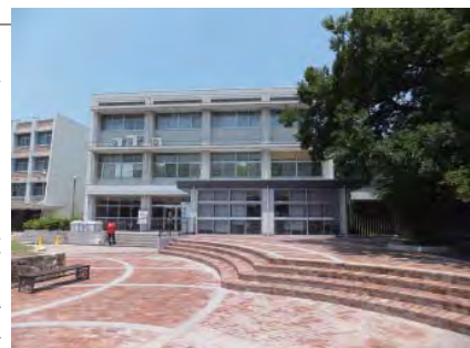
改修前の学生会館南面外観 手前はレンガ広場、写真右側の樹林地内には古墳がある。レンガ広場は、鍋屋上野浄水場で100年以上使用されていた古レンガを再利用。
