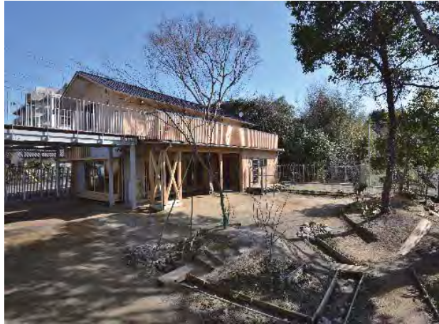
園舎外観。楓の木が2階デッキを貫いている
