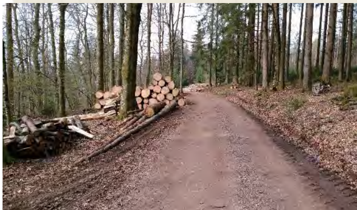
1軸11tのトラックにも耐えられる道。道のそばには搬出された材木や薪などがいたるところに用途別に現場で仕分けされ積まれている。
