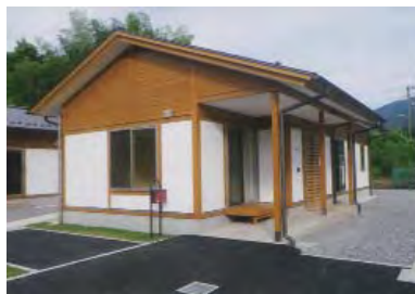
【外観】外壁：杉板貼（御杖産）・漆喰左官仕上
