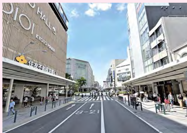
歩道拡幅された四条通（提供：四条繁栄会商店街振興組合）
