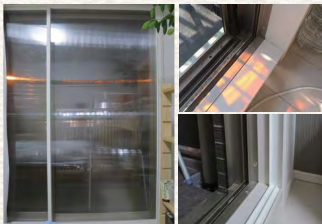
写真3：内窓設置前（右上）と設置後（右下、左）の様子
