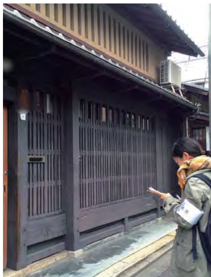
町家調査の様子：1軒ずつ現場で確認
