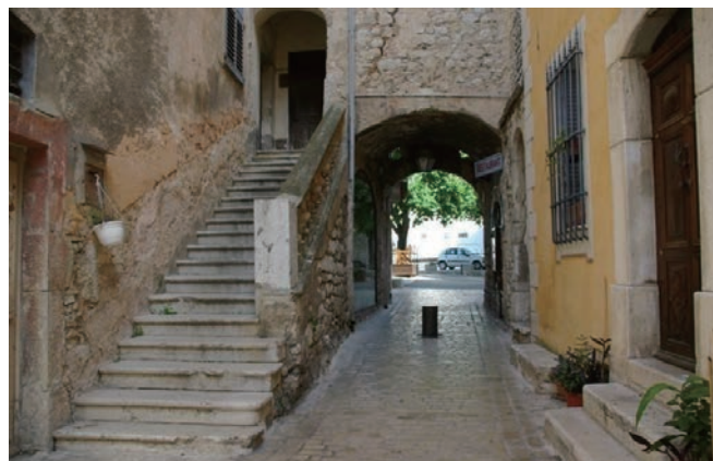
丁寧に整備されたりモコン昇降式車止め (トゥーレット・シュール・ルー)
