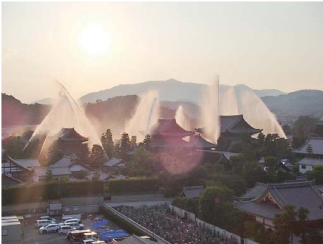
中心伽藍放水銃試験放水
