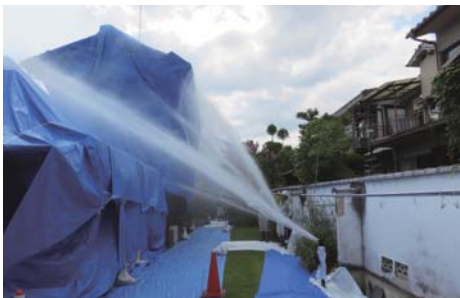
延焼防止ライン試験放水
